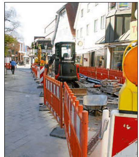
Aufatmen in der Marktstraße: Bald liegt das Kabel und die Arbeiten neigen sich dem Ende.
