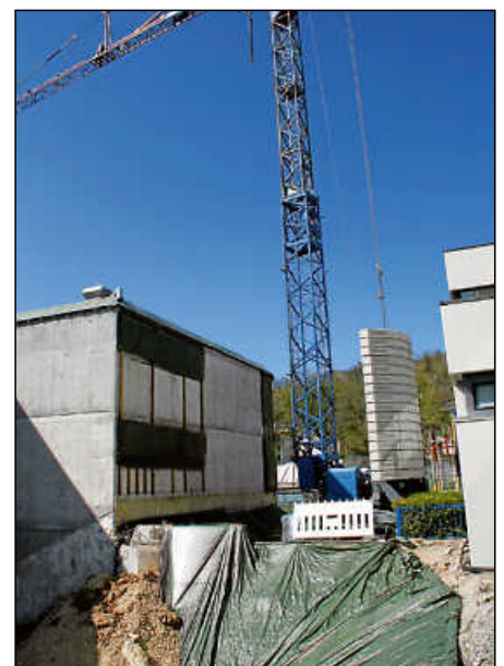
Inzwischen ist ein weiterer, dritter Kran auf dem Baufeld hinzugekommen.
