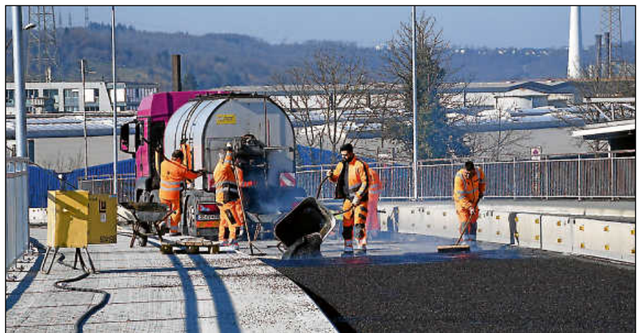
Neben der Betonsanierung wurde der Fahrbahnbelag der Brücken neu asphaltiert.
