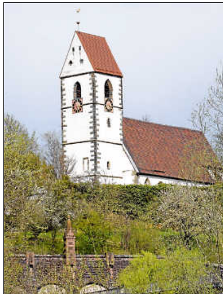
Plochingens Wahrzeichen ist nun über ein Jahr lang geschlossen. Die Stadtkirche wird vom Dach über den Innenraum bis zur Orgel saniert.
