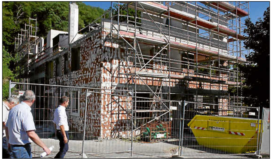
Das Gebäude der Stadtwerke am Pfostenbergweg wird kernsaniert, es wird um- und angebaut und es wächst, wie man sieht, in die Höhe.
