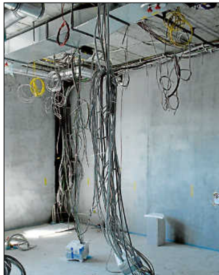
Hundert Kilometer Kabel hängen teils von Decken und Wänden und müssen noch verlegt werden.
