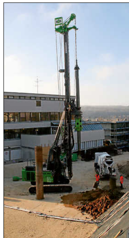
Im Kosten- und Zeitplan: Die Tiefgründungsarbeiten für den Erweiterungsneubau am Gymnasium haben begonnen.
