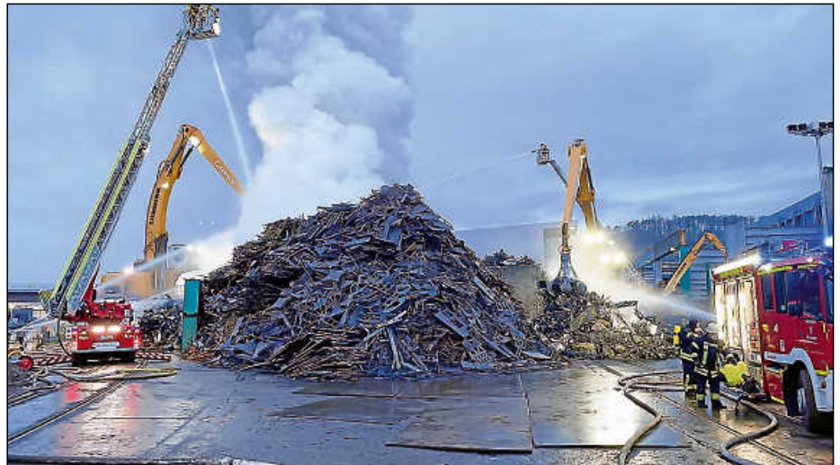
Gegen 7.30 Uhr brachten die Feuerwehreinsetzkkräfte den Brand unter Kontrolle.
