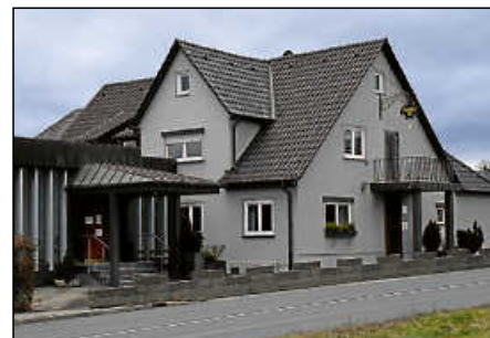
Das Gebäude des heutigen Restaurants blieb in seiner Grundstruktur erhalten.
