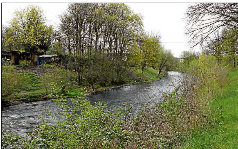
Sollte zur Verbreiterung der Fils die Uferböschung im Bereich des Kleintierzüchtervereins aufgeweitet werden (gegenüberliegende Uferseite), müssten vermutlich die Stallungen weichen.
