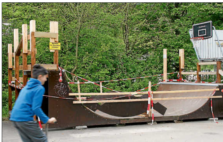
Die neu gebaute Rampe am Skateplatz wartet derzeit noch auf ihre Fertigstellung.
